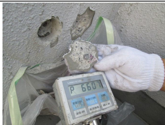
② 7~6階共用階段手摺壁 西面
