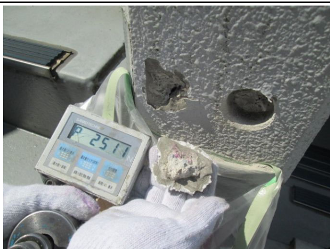
① 7~6階共用階段手摺壁 東面
