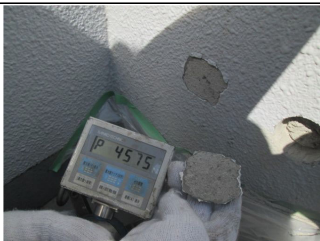
③ 7~6階共用階段手摺壁 南面
