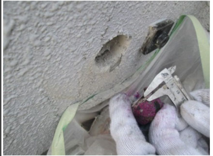
② 7~6階共用階段手摺壁 西面
