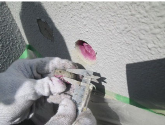
③ 7~6階共用階段手摺壁 南面
