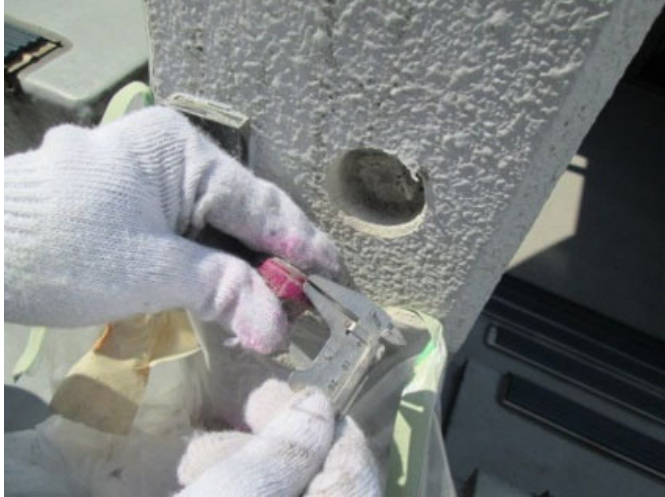
① 7~6階共用階段手摺壁 東面
