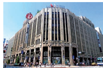
新宿区商業ビル
