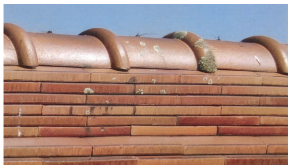
さらにズームすることで汚れや釘浮きまで撮影できます
